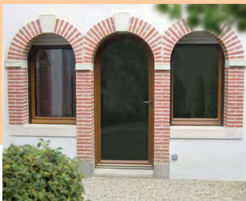
Porte-fenêtre plein cintre sans soubassement et fenêtres plein cintre.
