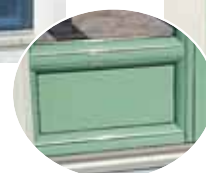
Détail d'un soubassement
