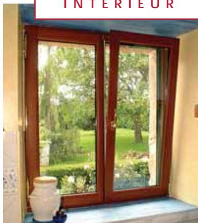
Oscillo-battant : à l'intérieur côté bois, à l'extérieur côté aluminium
